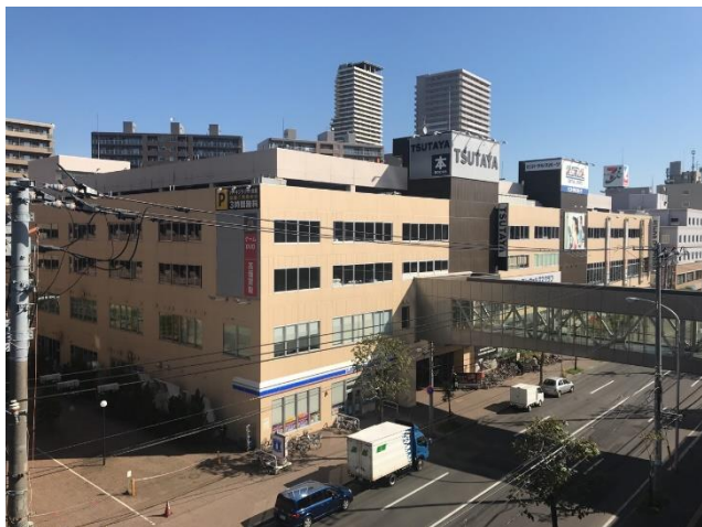
商業棟西側から撮影
