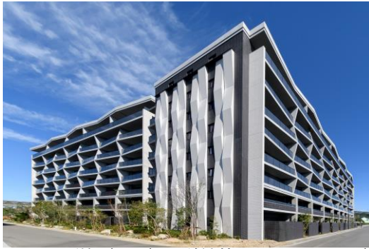
外観（レ・ジェイド新大村ステーションフロント）
