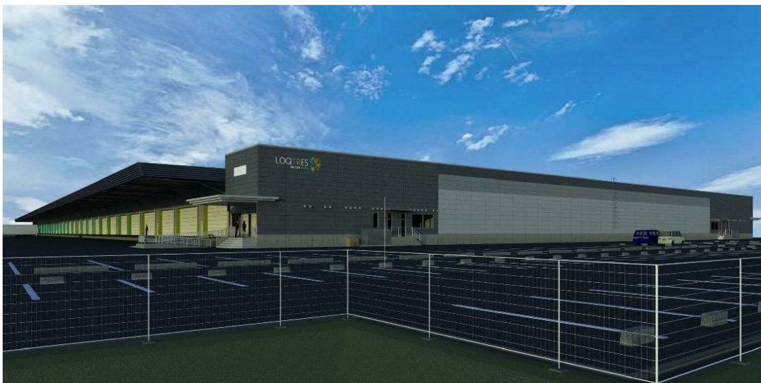
(仮称) LOGITRES(ロジトレス)東条外観完成予想パース
