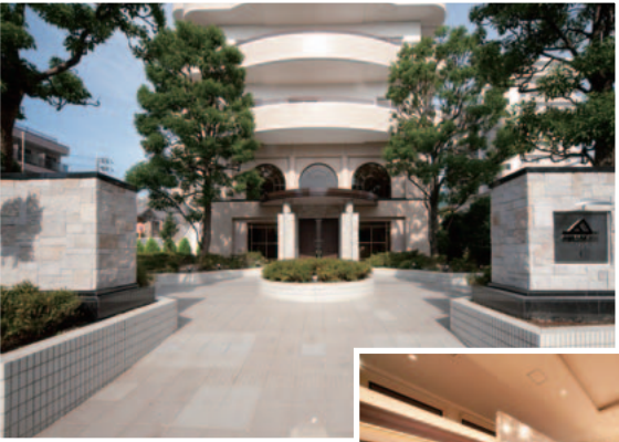
1 番館エントランス
