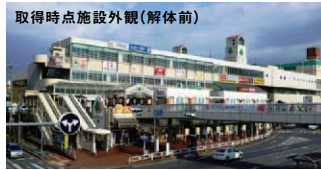
取得時点施設外観(解体前)
