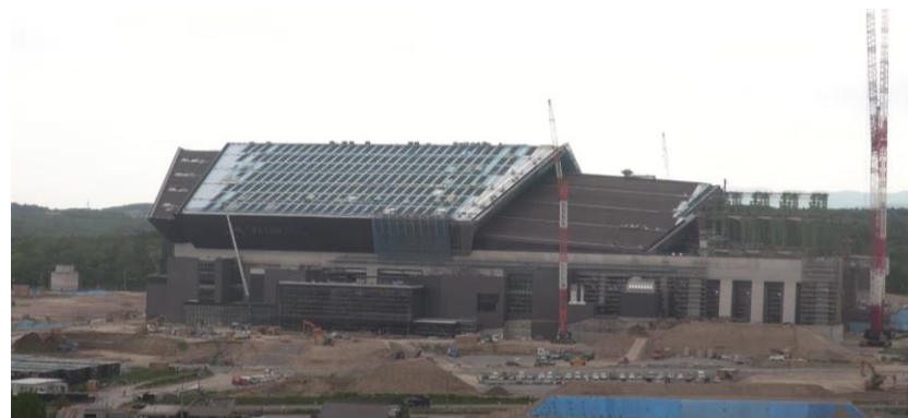
Fビレッジ工事状況（2022年6月）
