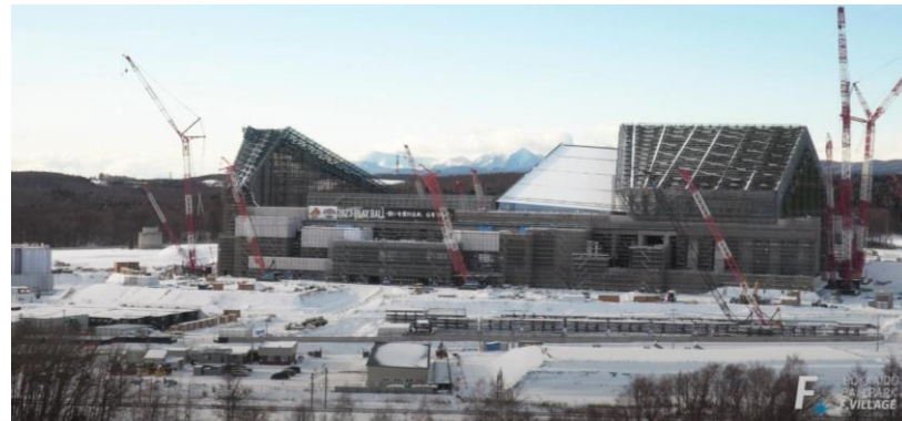
Fビレッジ工事状況（2021年12月）
