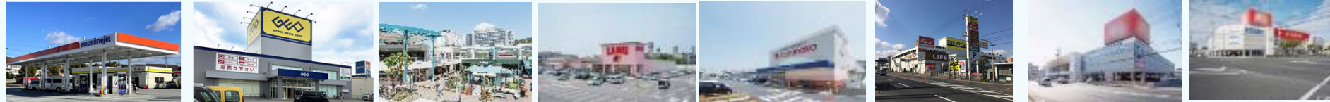
ENEOS伊川谷SS店 (底地) | GYO彦根高宮店 (底地) | tonarie南千里 | ラムー北津守店 (底地) | 山陽マルナカ水谷店 (底地) | ライフ大仙店 (底地) | ケーズデンキ西神戸店 (底地) | ケーズデンキ倉敷店 (底地)
