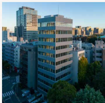
ESCON九段北ビル
