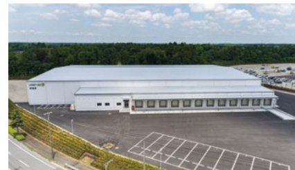
物流施設「LOGITRESちばりサーチパーク」
