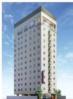
金沢市堀川新町 平成30年4月 開業 121室
