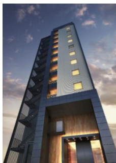
千代田区幸町 平成30年4月 開業 102室
