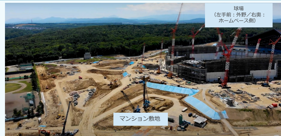
Fビレッジ現状 (2021年7月撮影) 球場の建設工事は約40%の進捗
