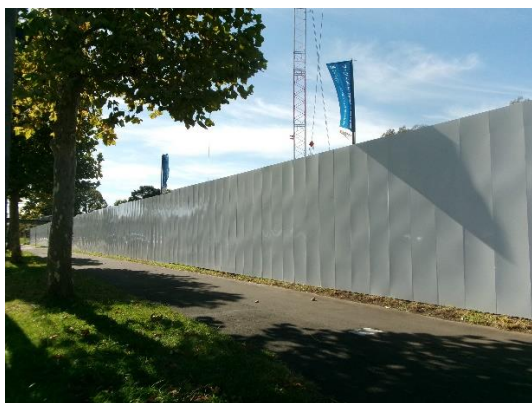
作業前の仮囲い
