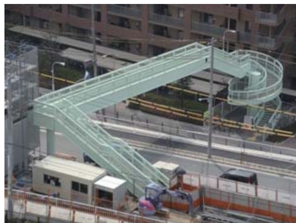
付け替えを実施した歩道橋
