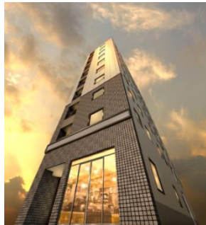
日本橋馬喰町 2017年4月 開業 63室
