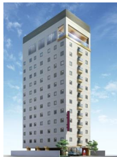
金沢市堀川新町 2018年4月 開業 121室
