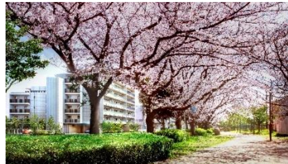
外観完成予想図(太尾堤緑道から望む北西面外観)
